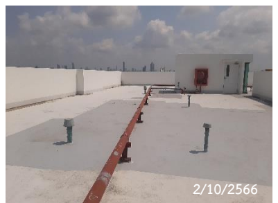
ท่อระบายอากาศบนชั้นดาดฟ้า
